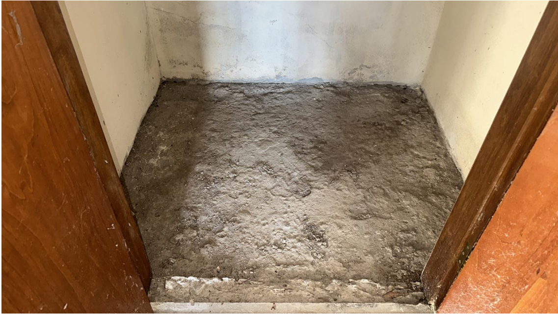
Foto 46: Piso do poço para implantação de elevador - Câmara Municipal de Mucugê..
