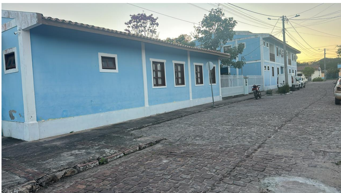
Foto 41: Paredes externas que serão pintadas - Câmara Municipal de Mucugê.
