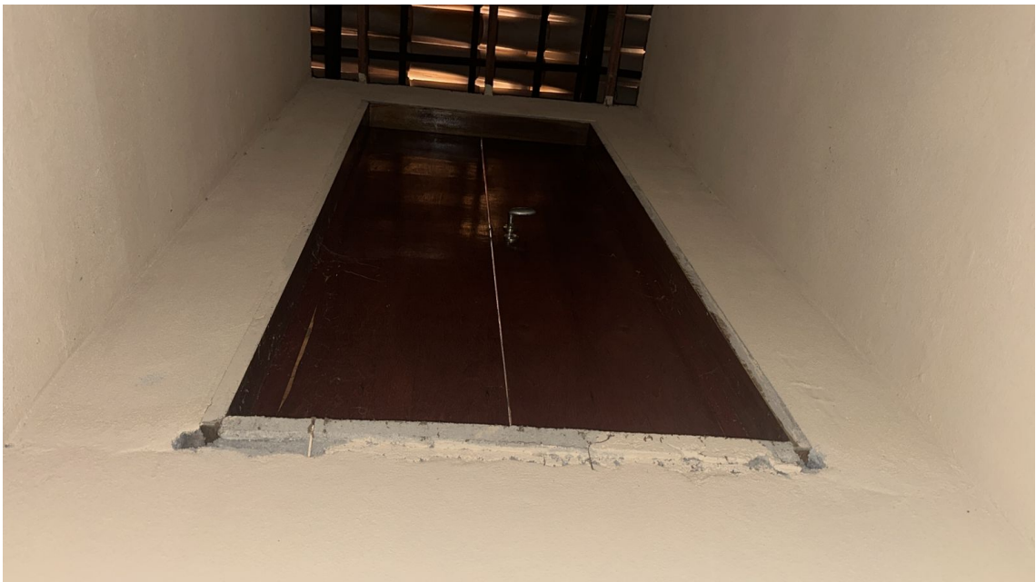
Foto 45: Porta do poço para implantação de elevador - Câmara Municipal de Mucugê.
