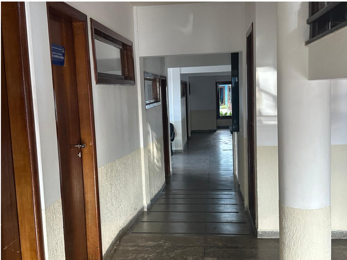
Foto 47: Paredes internas que receberão textura e tintura - Câmara Municipal de Mucugê.
